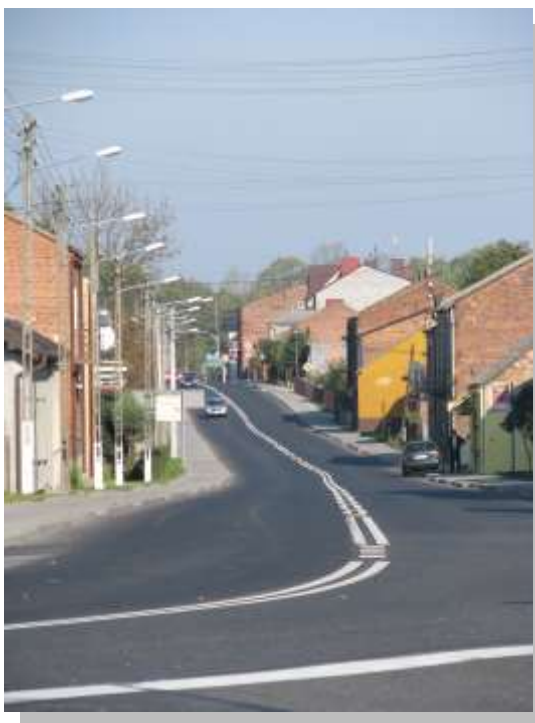
Foto. Droga krajowa nr 42 w Nowej Brzeźnicy
