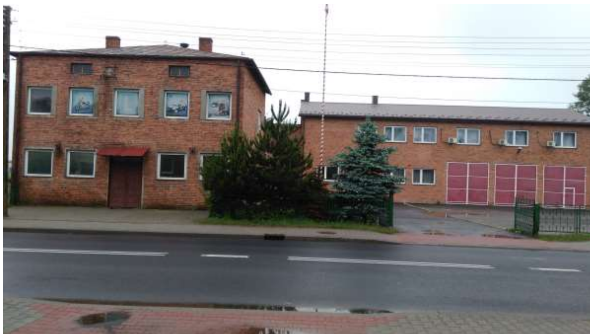
Foto. Budynek OSP w Nowej Brzeźnicy Źródło: zasoby gminy
